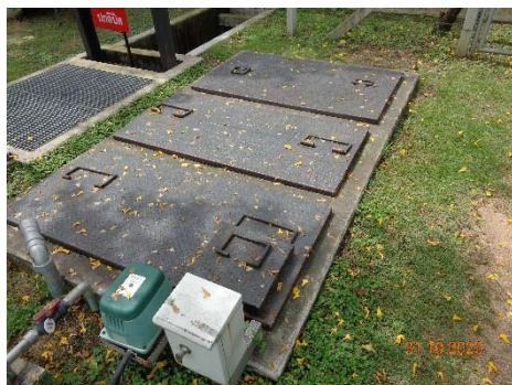
ภาพที่ 2-10 บ่อตรวจสอบ (Inspection Pit) และบ่อพักน้ำทิ้ง (Holding Pond)
