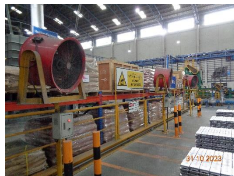
ภาพที่ 2-23 พัดลมระบายอากาศ บริเวณเสี่ยงต่อการสะสมความร้อน
